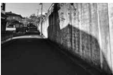
磯崎白萩地区擁壁
