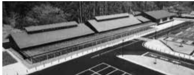
石田沢防災センター
