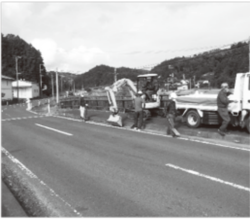
▲土砂撤去作業の様子
