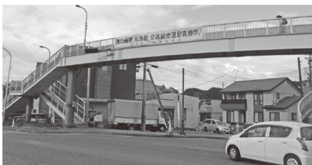
▲交通安全協会により設置された横断幕
