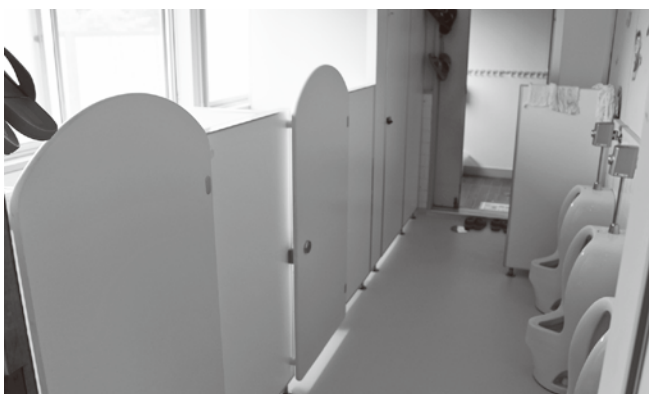
高城保育所感染症対策トイレ改修工事（町民福祉課）
