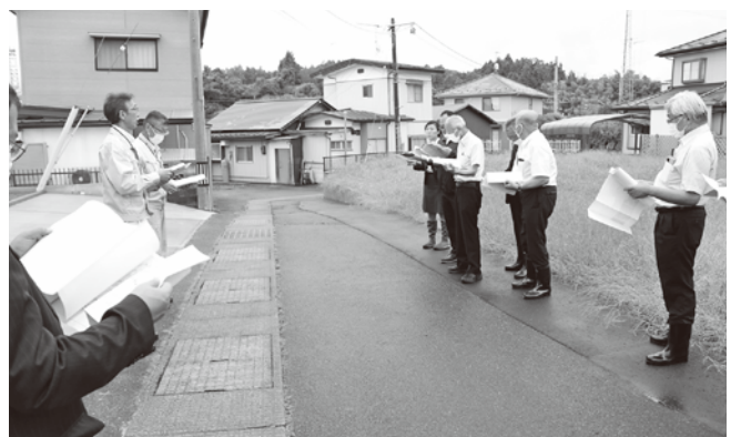
品井沼地区道路整備工事（建設課）
