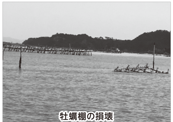
鶴田川周辺の被害状況視察
