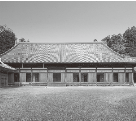
改修後の瑞巖寺本堂
