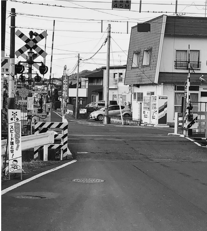
拡幅工事をする第2磯崎踏切
