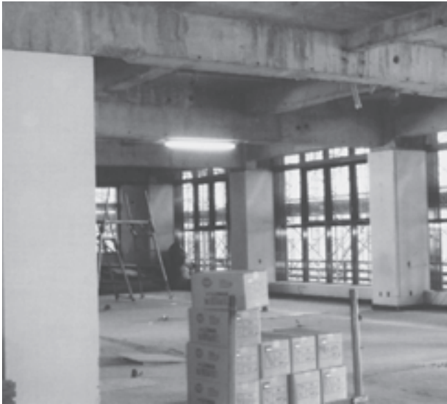
改修中の松島中央公民館
