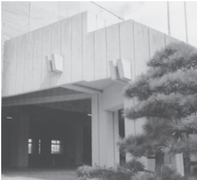
改修中の中央公民館
