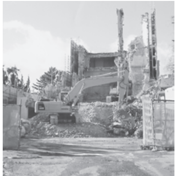
解体中の旧ロイヤルホテル
