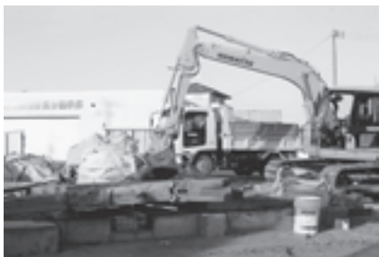
解体中の北松島公会堂
