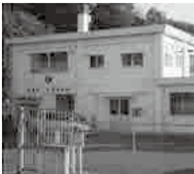
二子屋 浄水場
