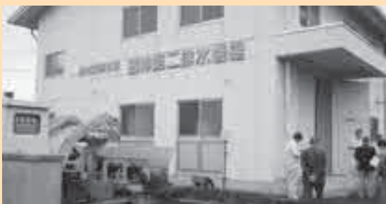
◀ 銭神第二排水機場
